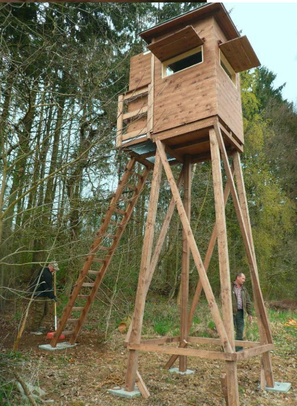
Hohen Komfort bietet die geschlossene Kanzel. Sie ist gedämmt und mit Teppichboden ausgeschlagen
